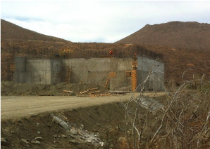
Construcción de mega cisternas en Tres Santos
